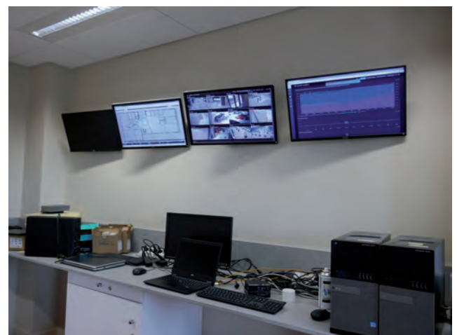
Salle de contrôle permettant à la fois d'interagir avec le prototype et d'observer les cycles de vie des "bâtiments".
