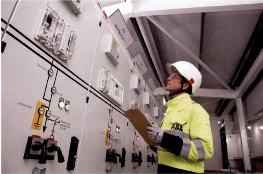
► Maintenance de tableaux électriques ABB.
